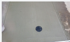
Reparación permanente de la acera esquinera.
